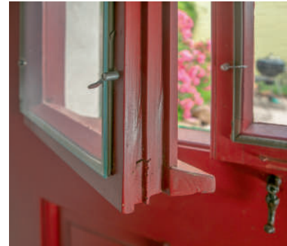
Kleine Maßnahme mit Wirkung: Der Wärmeschutz der einfach verglasten Fenster dieser Haustür, wurde an der Innenseite mit Vorsatzscheiben und einer umlaufenden Dichtung verbessert.
